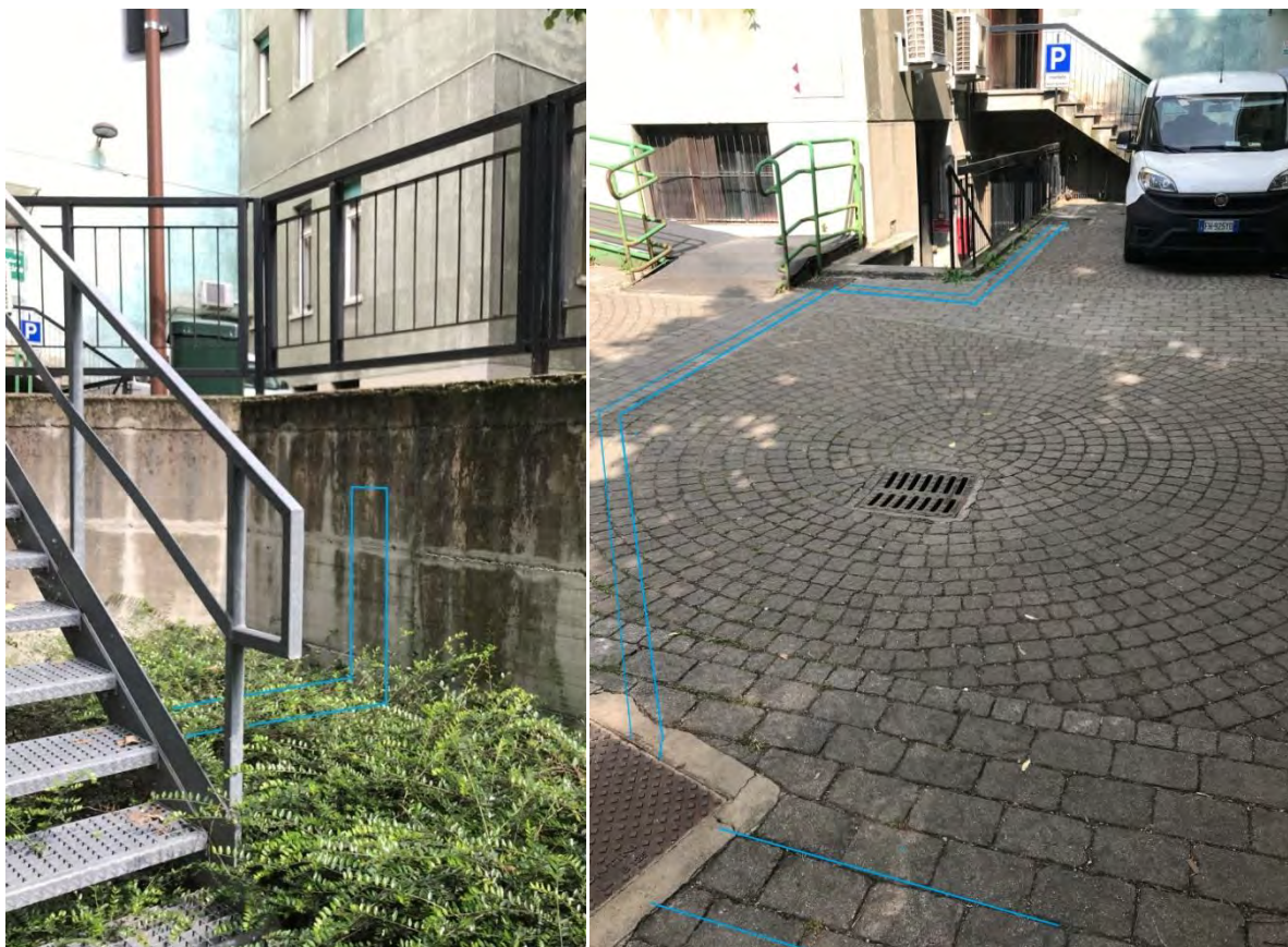
Foto 1 - Percorso tubazione collegamento centrale antincendio-mensa in uscita da carotaggio muro di contenimento piano di campagna (foto di sinistra). Percorso tubazione collegamento centrale antincendio-padiglione servizi verso cunicolo tecnico esistente (foto a destra).
