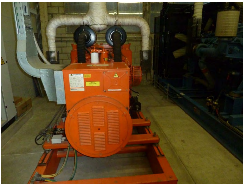
Figura 6 – Gruppo elettrogeno servizi di sicurezza in cabina elettrica C
