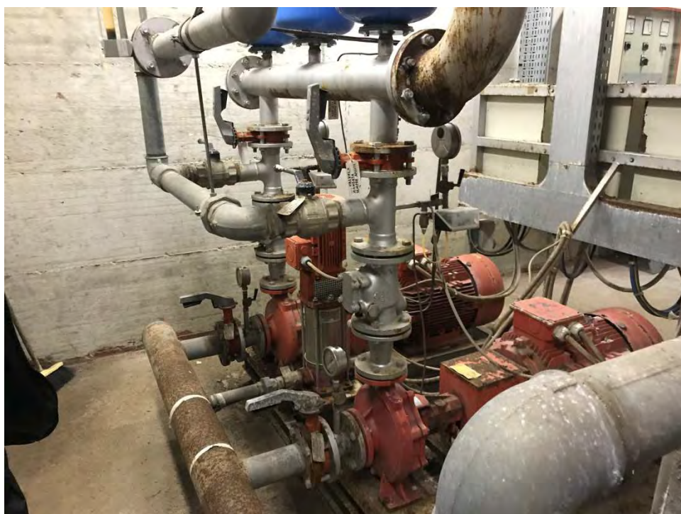
Fig. 1 - Gruppo di pompaggio elettropompa 1 e 2, più pompa pilota.
