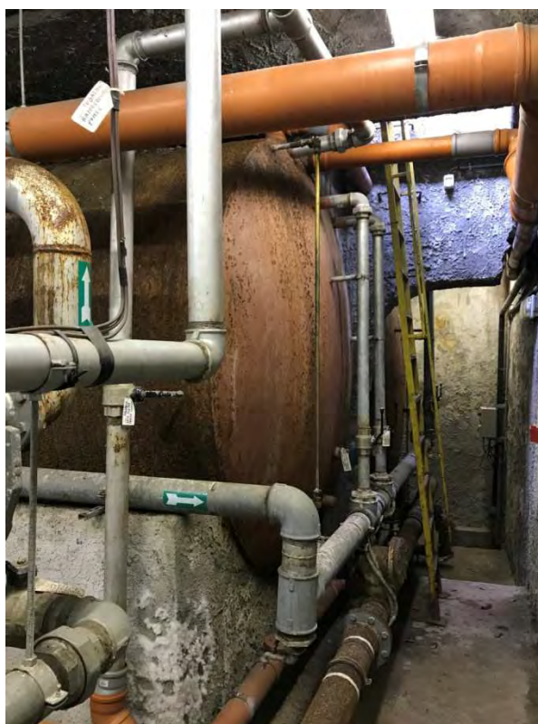
Fig. 2 - Serbatoi per riserva idrica.
