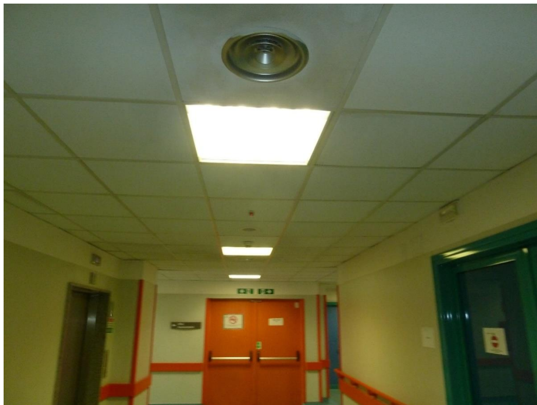
Figura 7 – Apparecchi illuminanti di sicurezza con gruppo autonomo e di tipo combinato Monoblocco A - piano ottavo
