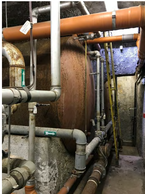
Fig. 1 - Gruppo di pompaggio elettropompa 1 e 2, più pompa pilota.
